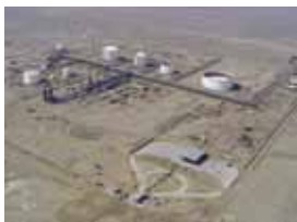
PLANTA LNG LOBERIA - CAMISA/PLUSPETROL
