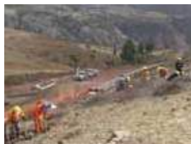
GASODUCTO - PERU LNG
