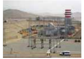
CENTRAL TERMICA LAS FLORES - DUKE ENERGY
